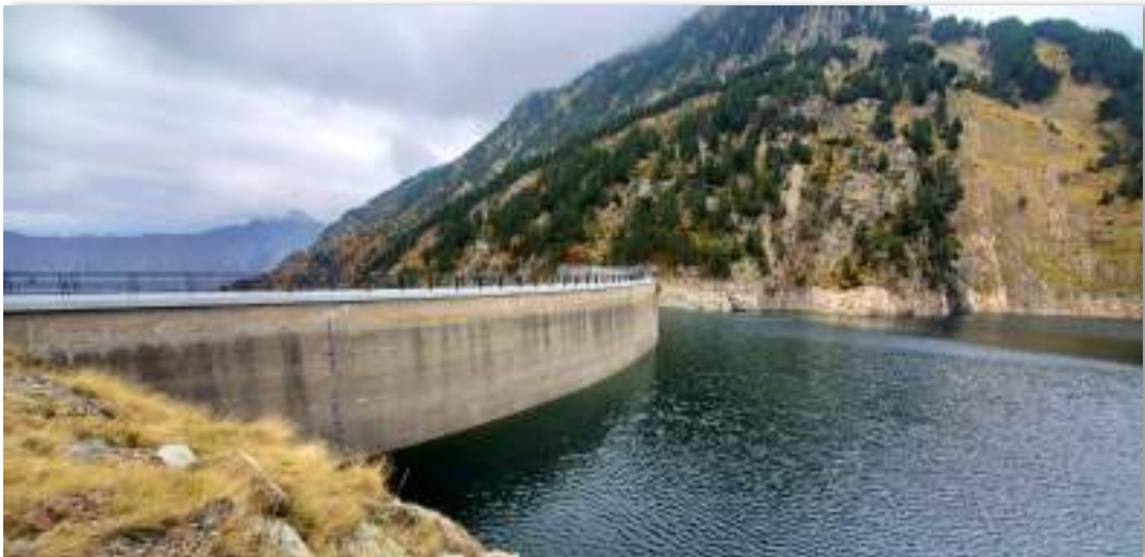
Barrage-route de Naguilhes (© L. Poudré)
