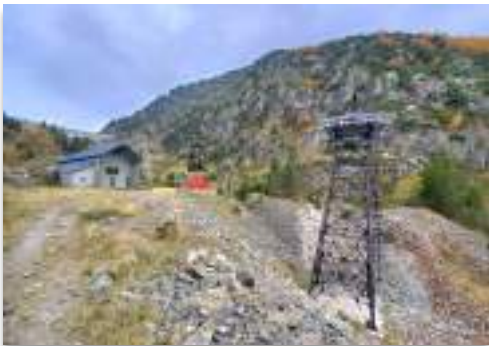
Gare d’arrivée du téléphérique EDF de Naguilhes (© L. Poudré)
