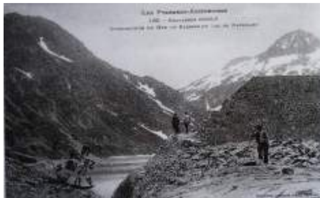
Carte postale ancienne illustrant la construction du premier barrage de Naguilhes
