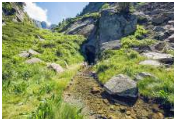
Canal de délivrance du débit réservé d'En Beys, vers le lac de Gourg Gaudet
