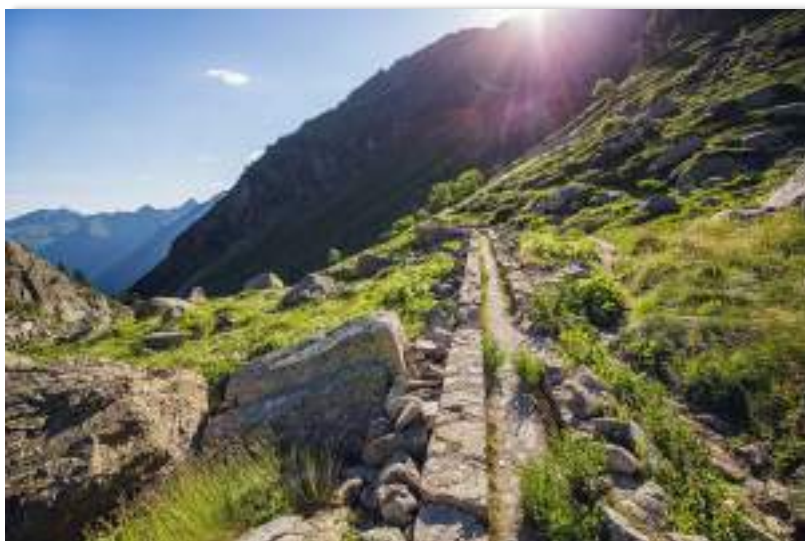
Canal maçonné d'En Beys, servant par le passé à recueillir les eaux de ruissellement pour les acheminer dans l'étang (© OFB)
