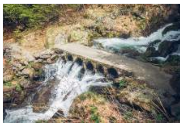
Passage busé dans la montée vers Baxouillade
